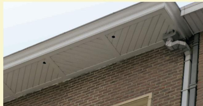
*Trous réalisés dans la corniche d'un bâtiment, lors d'une réfection de toiture*
