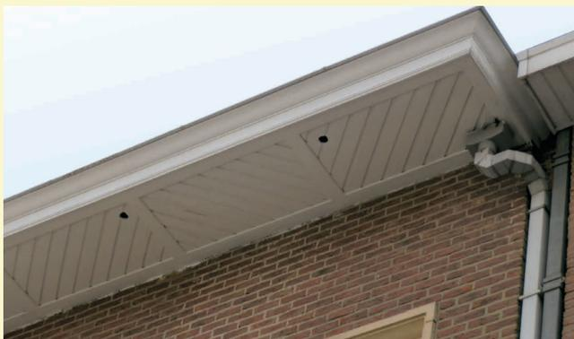
Trous réalisés dans la corniche d'un bâtiment, lors d'une réfection de toiture
